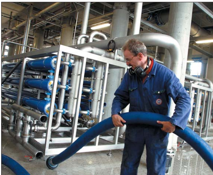
Brouwerij Bavaria bespaart water door toepassing van RO op grondwater.
